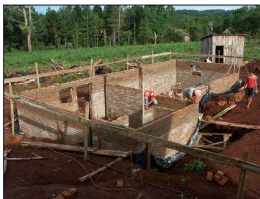
Der Keller ist schon beinahe fertig
