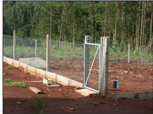
Der fertige Gartenzaun mit selbstschliessendem Tor
